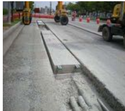
(d) Placement of pre-cast system
