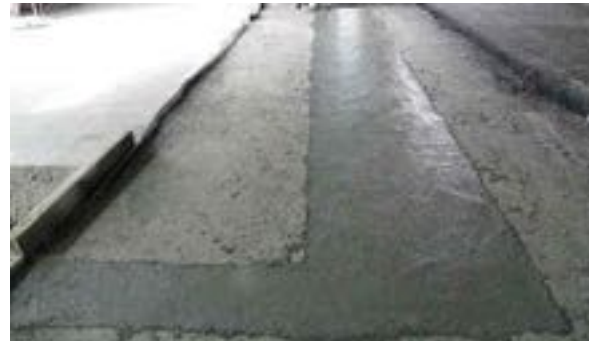
(d) 2 nd Concrete layer
